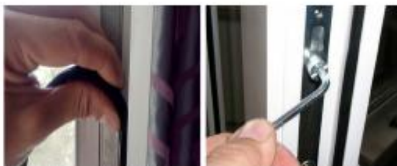
Рисунок 1 – Виды ремонта пластиковых окон
